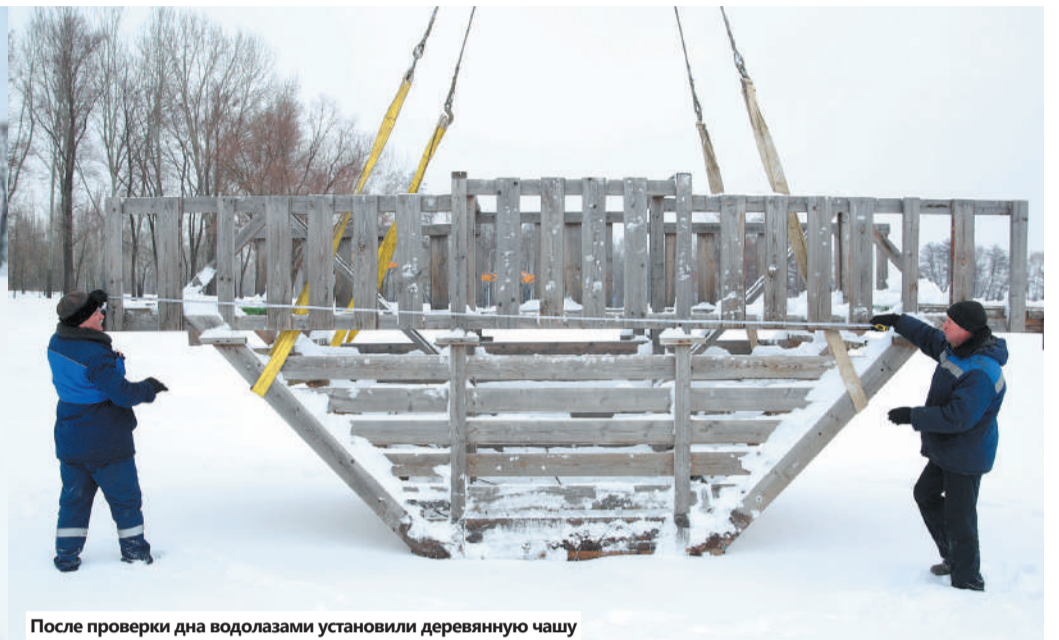
После проверки дна водолазами установили деревянную чашу
